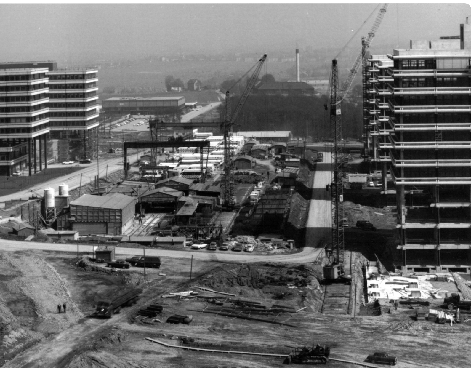
Foto: Ruhr-Universität Bochum Baustelle 1967
